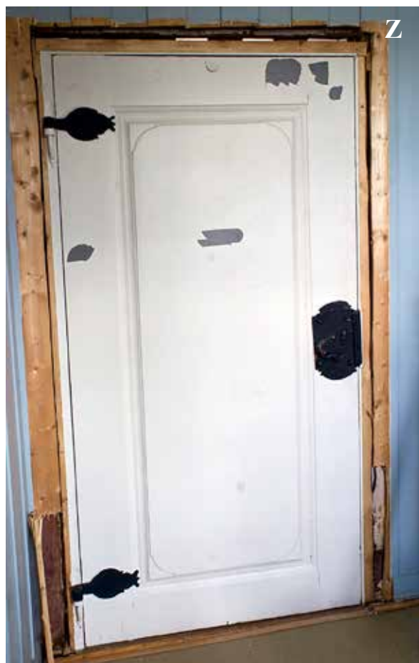
Over: Døren fra rom 202 til rom 201. Tilsvarende gerikter oppsatt sammen med skyggepanelet. Her demontert.
