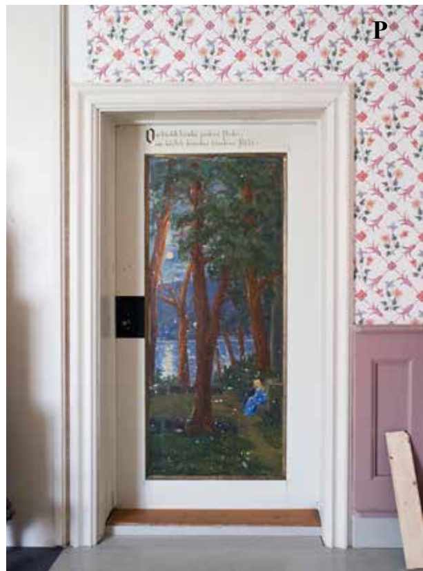
Slettsiden av barokk/rokokkodøren inn til rom 209 som opprinnelig var slått sammen med rom 210. Denne døren er åpenbart flyttet og i veggens ca 1 meter vestover er det en gjentatt åpning hvor døren kan ha sittet frem til det ble oppført garderobekap akkurat her. Situasjonen er avmerket på tegning fra 1950.
