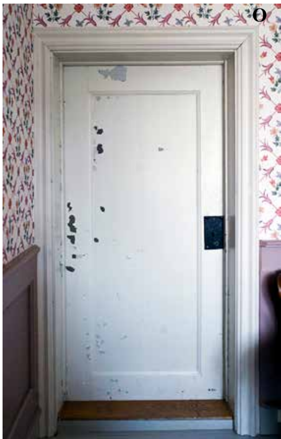
Slettsiden av barokk/rokokkodøren inn til rom 208. Tilsvarende andre dører i etasjen fra samme tid. Står etter alt å dømme på sin opprinnelige plass
