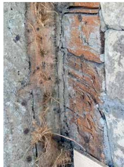
Over: Snitt av ytterveggen, Storstua. Øverst laft, under reparasjon i bindingsverk. Under: Storstuehjørnet mot nordvest. Avkappede laft (venstre/midten), deretter utmurt bindingsverk (til høyre).
