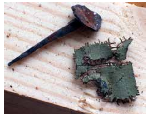
Det er rester av malt lerret på tømmeret på tre av Storstuas vegger.
